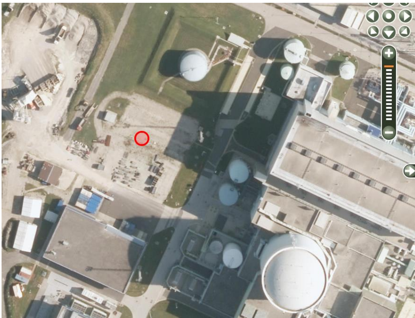
Slika 2: Prikaz območja obravnave. Z rdečo je označen centroid območja gradnje.
